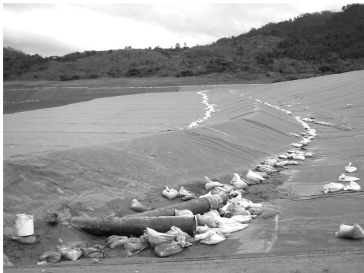
Con una preparación y prevención adecuada se hubieran tomado las medidas necesarias para que las conexiones de la tubería quedaran debidamente cerradas y rotuladas
